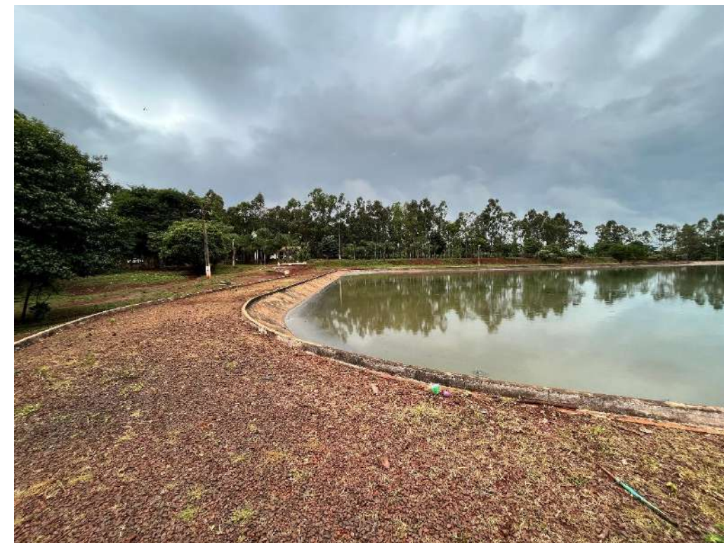
Figura 49: Sistema Sede – Esgoto – Lagoa facultativa Fonte: Visita ao município
