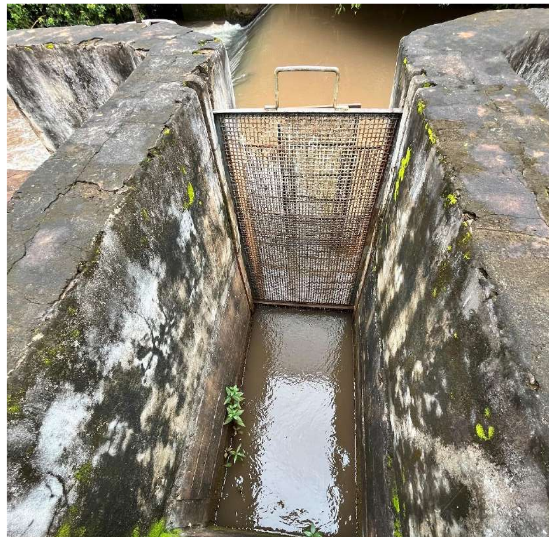
Figura 28: Sistema Sede – Água – Grade
