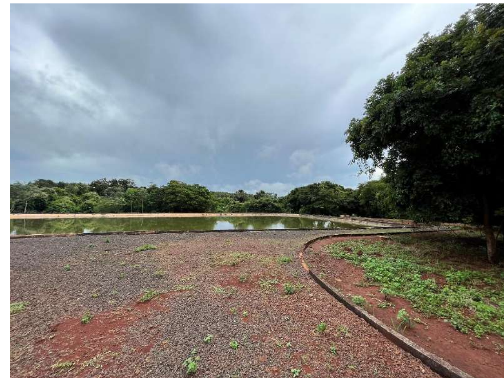
Figura 45: Sistema Sede – Esgoto –Lagoa de decantação
