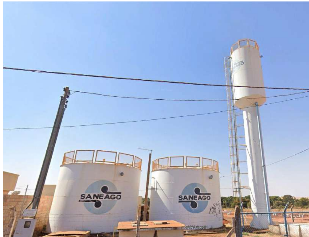
Figura 39: Vazamento R Sistema Sede – Água – REL 4 e RAP 1 e 2.
