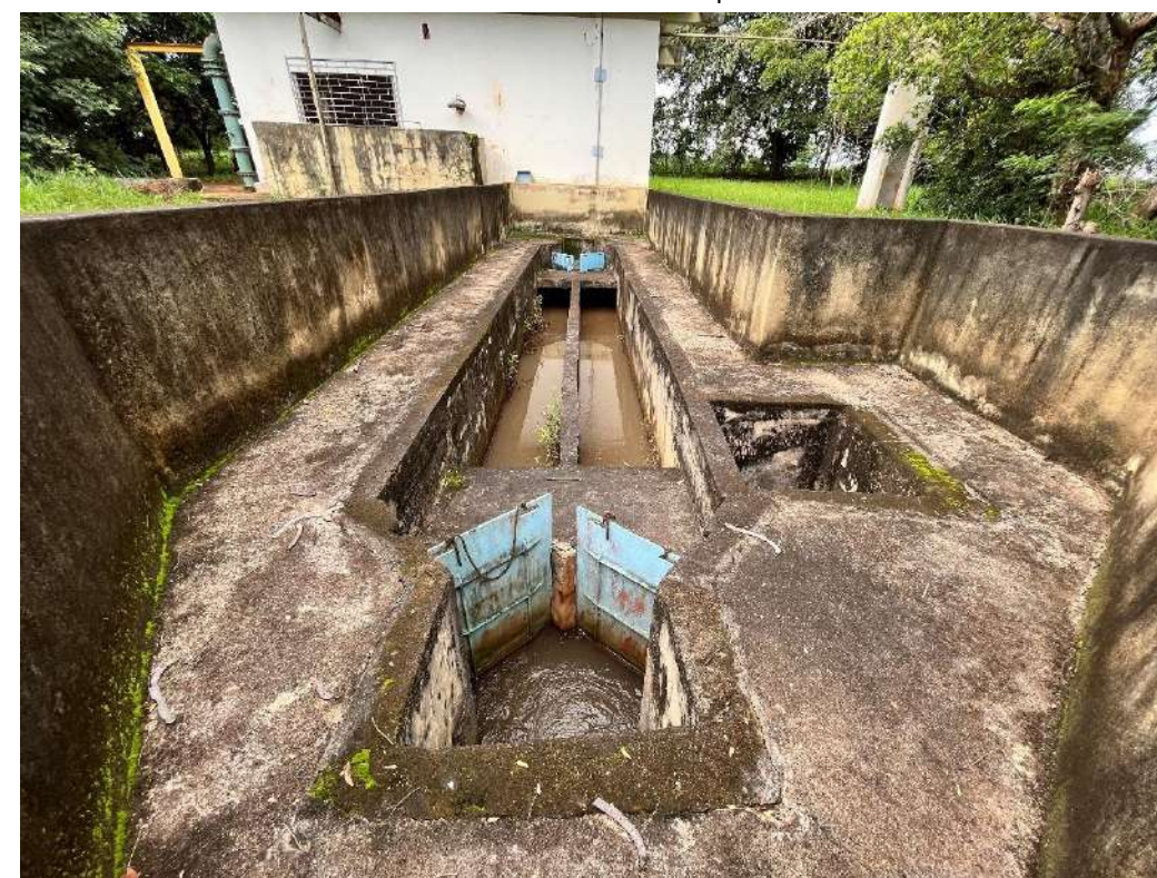
Figura 25: Sistema Sede – Água – Caixa de areia na captação - sede. Fonte: Visita ao município.
