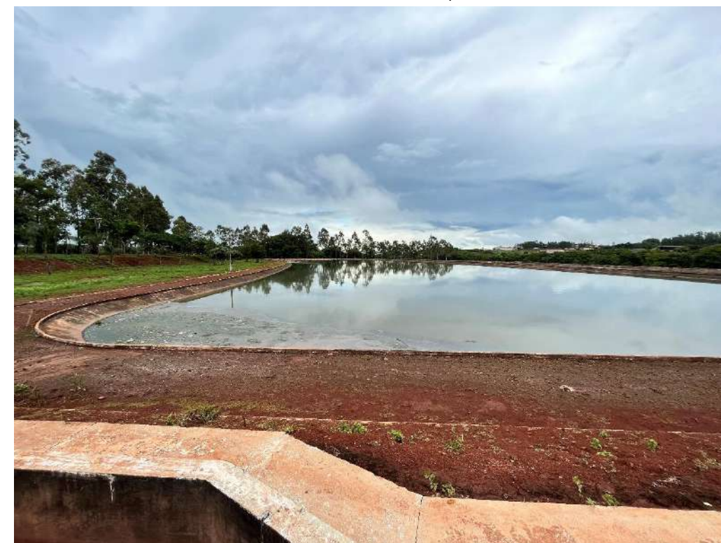
Figura 50: Sistema Sede – Esgoto – Lagoa facultativa Fonte: Visita ao município
