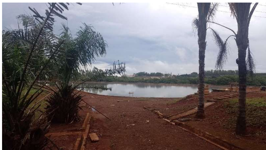
Figura 52: Sistema Sede – Esgoto – Lagoa facultativa Fonte: Visita ao município
