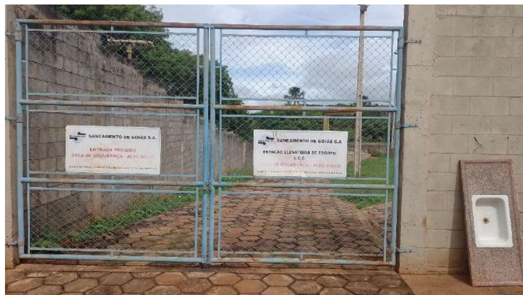
Figura 54: Sistema Sede – Esgoto – Estação elevatória de esgoto.
