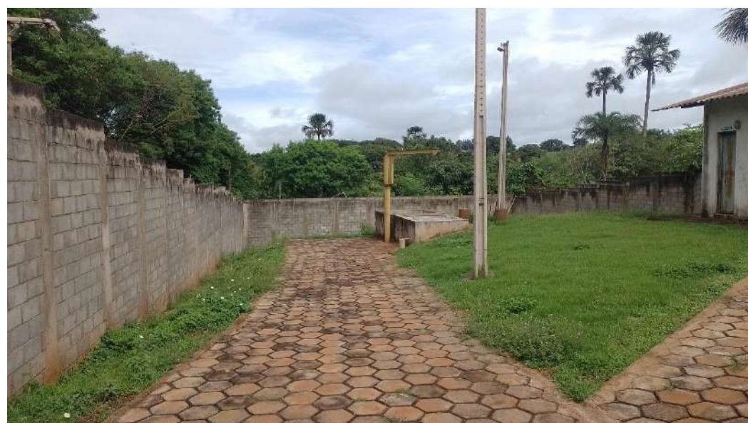
Figura 55: Sistema Sede – Esgoto – Estação elevatória de esgoto.
