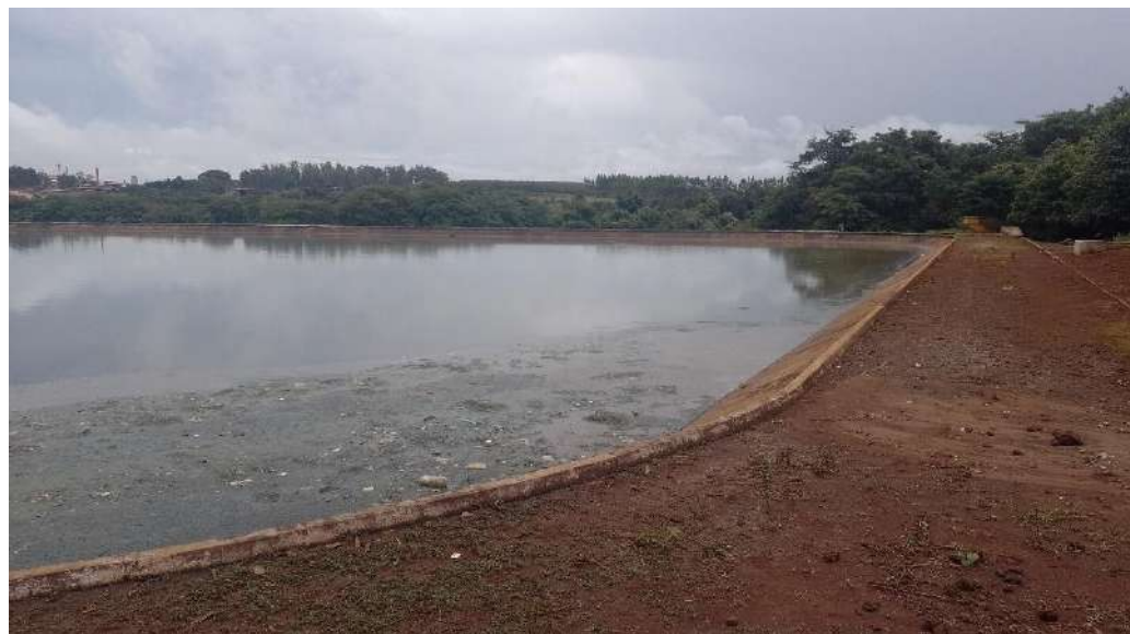
Figura 43: Sistema Sede – Esgoto – Lagoa facultativa
