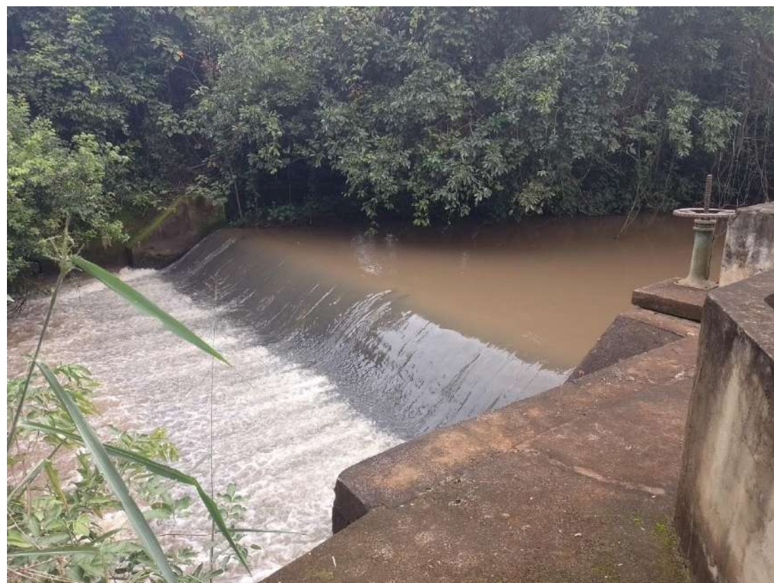
Figura 23: Sistema Sede – Água – Captação sede – Barragem de nível no Ribeirão Bom Jesus Fonte: Visita ao município.
