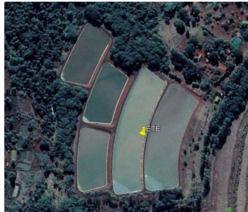
Figura 53: Sistema Sede – Esgoto – Lagoa facultativa Fonte: Visita ao município
